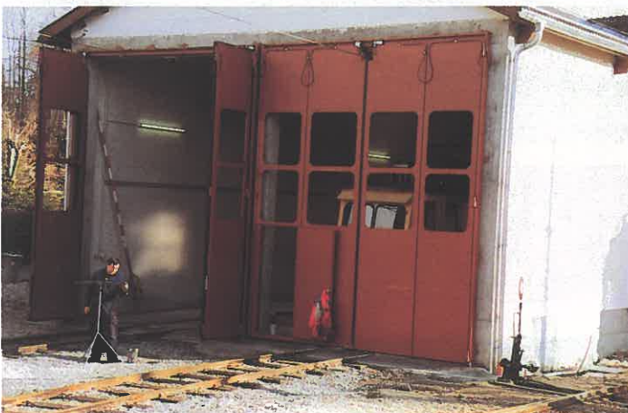
Atterseebahn: Modern, sachlich und sauber ist die neue Wagenhalle in Attersee, die anstelle des abgebrannten Gebäudes errichtet wurde. Hier können auch Reparaturen durchgeführt werden. Farbfoto: Manfred Reinsfelder
