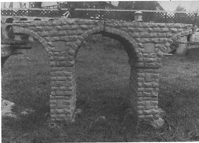
Kompletter Viaduktbogen, der aus vier Betonformteilen zusammengesetzt worden ist.
