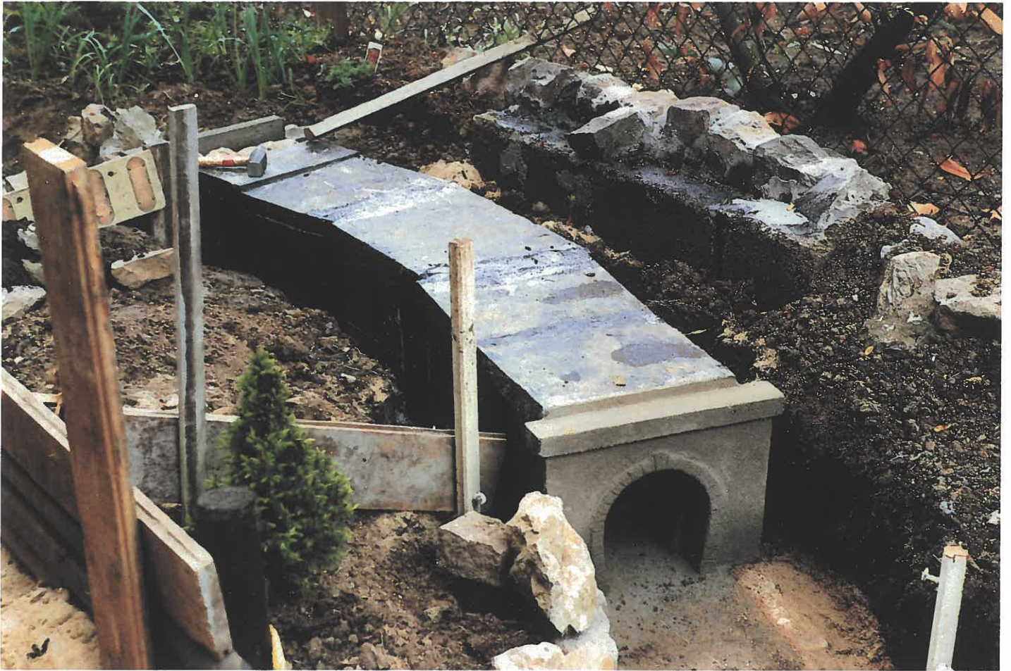
Tunnelbau aus Betonformteilen.
