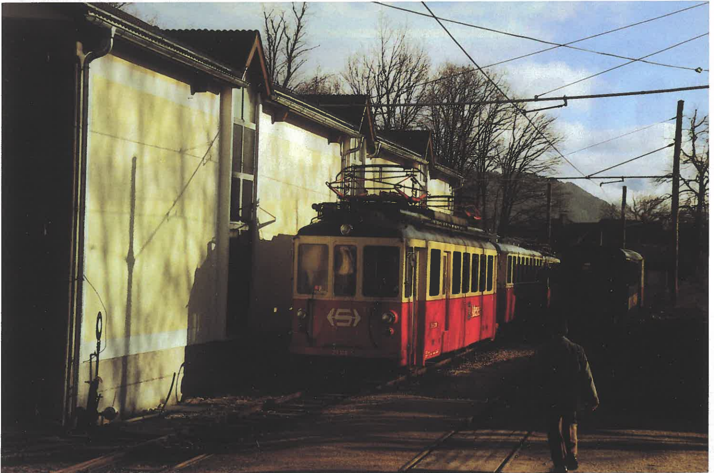
Atterseebahn: Die neue Wagenremise in Attersee (zwar modern gebaut, aber mit reizvollen architektonischen Attributen versehen) wurde bei tiefstehender Dezembersonne fotografiert. Neben dem Depot steht vorn Triebwagen ET 23 108 (ex AOMC/Schweiz 111, ex Lokalbahn Gmunden-Vorchdorf), der als Ersatz für durch das Feuer vernichtete Fahrzeuge zur Lokalbahn Vöcklamarkt-Attersee kam. Farbfoto: Manfred Reinsfelder
