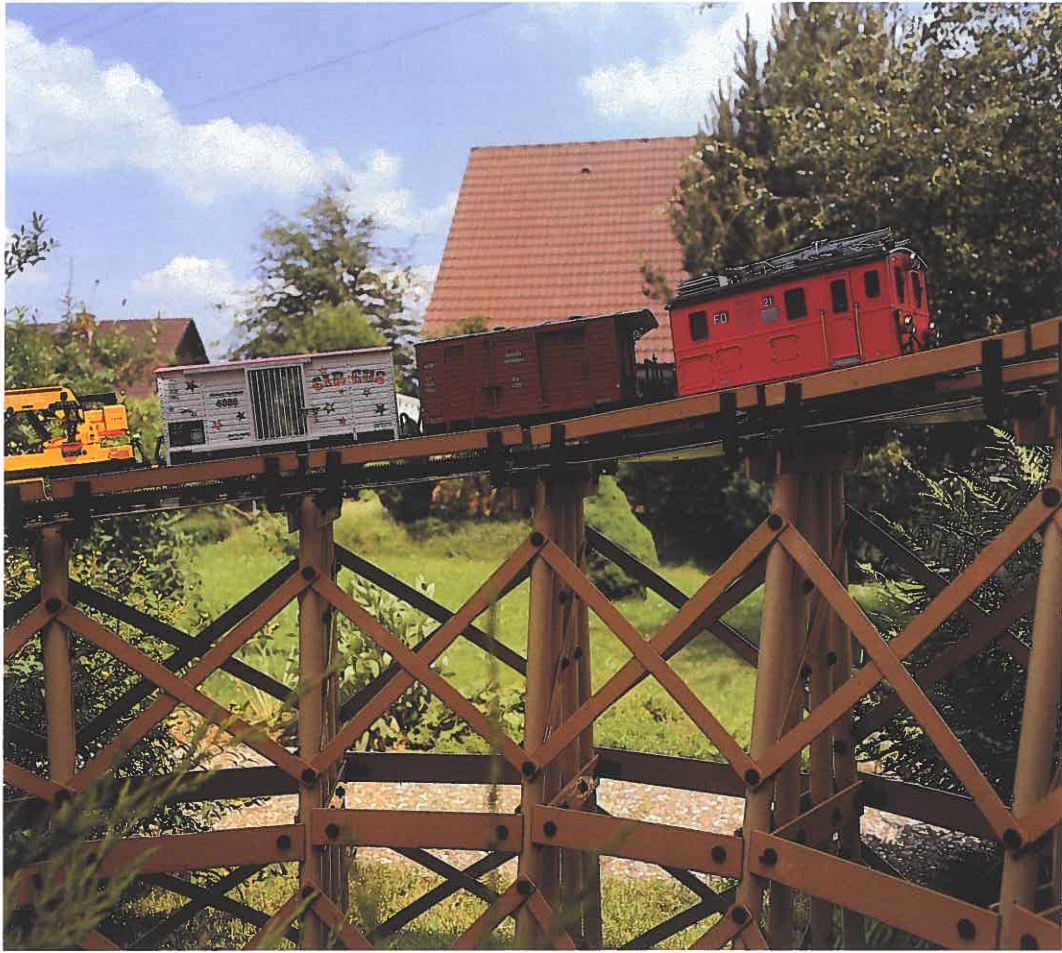
Trestlework-Brücke mit Zahnradbahn.
