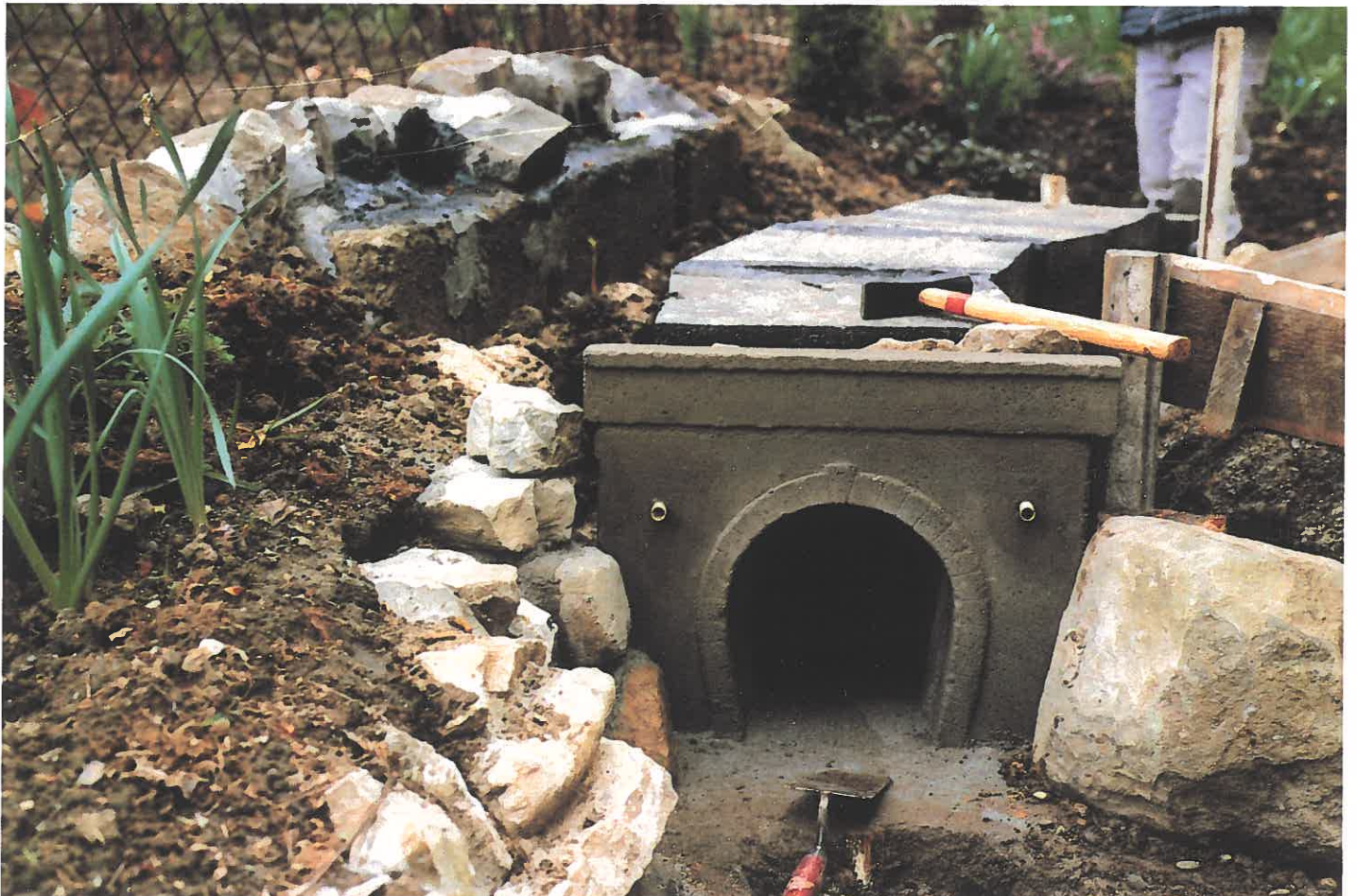
Steile Böschungen sind durch aufgemauerte Natursteine gesichert. Bemerkenswert gelungen ist das als Betonguß gefertigte Tunnelportal.
