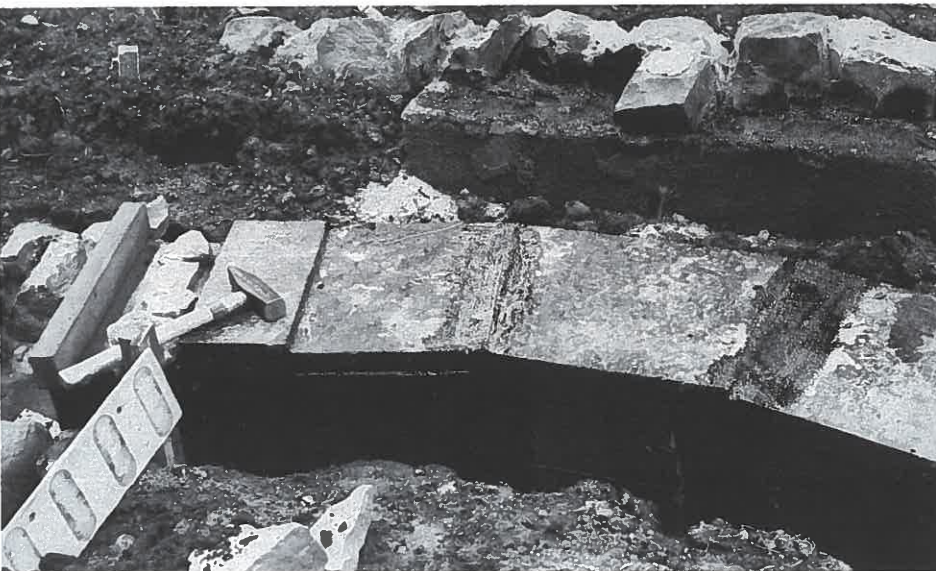
Die Betonformsteine wurden mit Kaltbitumen gestrichen. Sie werden dadurch gegen Feuchtigkeit geschützt.
